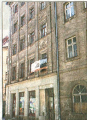
Das Eckhaus Weberstraße 13 wird mit 26 704 Euro bezuschusst. Fotos: Jens Trenkler
